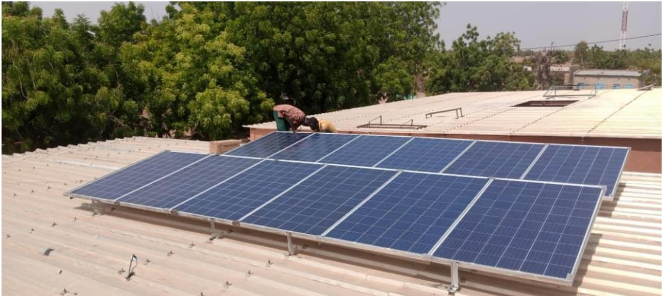
Da una settimana, l'impianto fotovoltaico del CSPS di Pissilà funziona regolarmente: 12 pannelli da 275 watt cadauno sono stati installati sul tetto in lamiera del dispensario e producono energia per 3,3 kwh.
