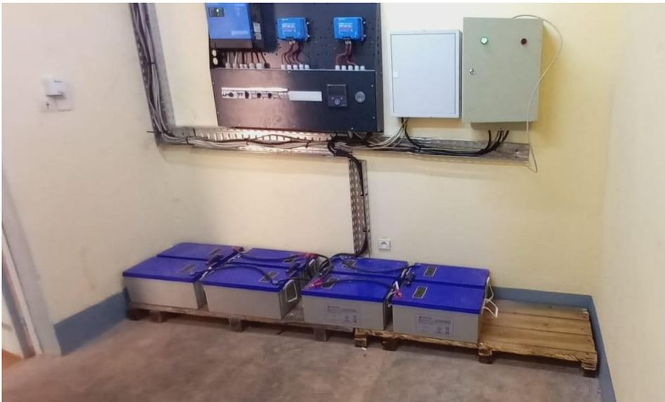
Nella sala tecnica 8 batterie da 200ah sono in grado di erogare 800ah a 24 volt.
